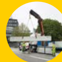
Etablering. Utsättning, tillsyn, avetablering
